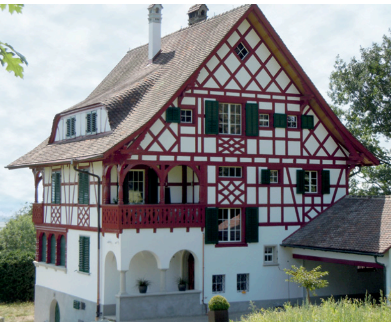
Ein klassischer Anwendungsfall für Ölfarben sind die offen liegenden Holzriegel von Riegelbauten. Das Haus steht bei Hüttwilen im Thurgau.
