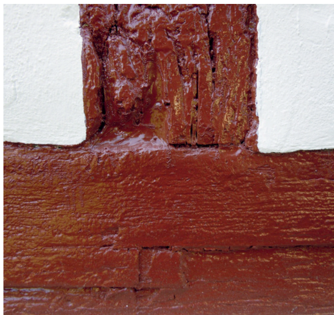
Ein klassischer Anwendungsfall für Ölfarben sind die offen liegenden Holzriegel von Riegelbauten. Das Haus steht bei Hüttwilen im Thurgau.
