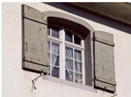
Rekonstruktion eines barocken Fensters in IV-EV mit festem Kämpfer.
