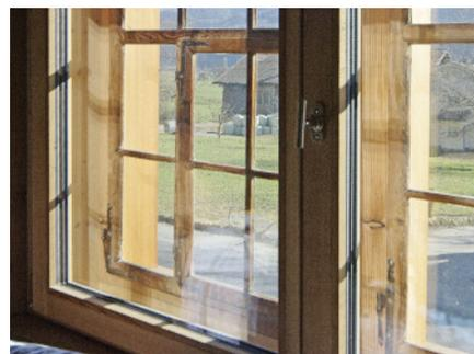
Kastenfenster auf der Innenseite zur Erhaltung der feinteiligen Fenster mit Lüftungsflügel an der Fassade.
