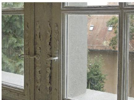
Barockes Fenster mit alten Beschlägen, an dem die einzelnen Glasscheiben durch eine dünne Isolierverglasung ersetzt wurden.
