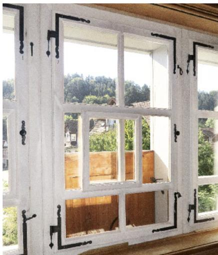
Nachbau Schieberfenster mit Isolierverglasung.
