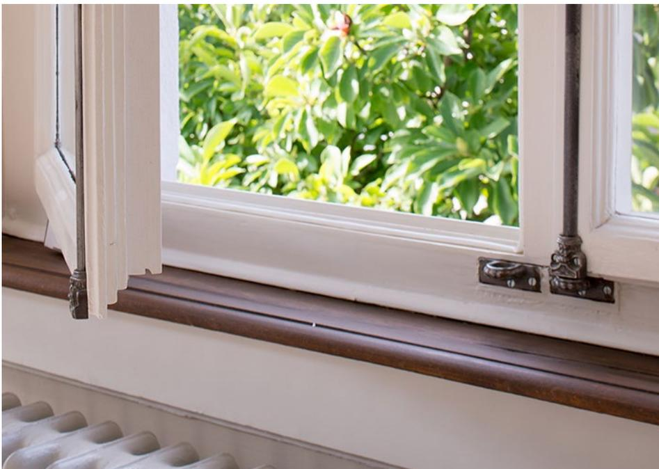
Der bestehende Rahmen mit Einfachverglasung wird hier aussen mit einer zusätzlichen Glasebene aufgedoppelt, U-Wert etwa 2.6.
