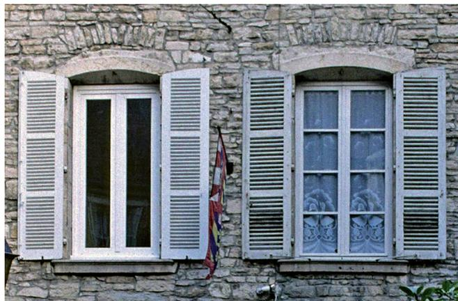
Ersatzfenster (links), das wegen fehlender Sprossen, zu breiter Flügelrahmen sowie falsch gewählter Materialisierung und Farbe die Qualität des Originals (rechts) in jeder Hinsicht verloren hat. Bild: NIKE Bulletin Nr. 5/2004.
