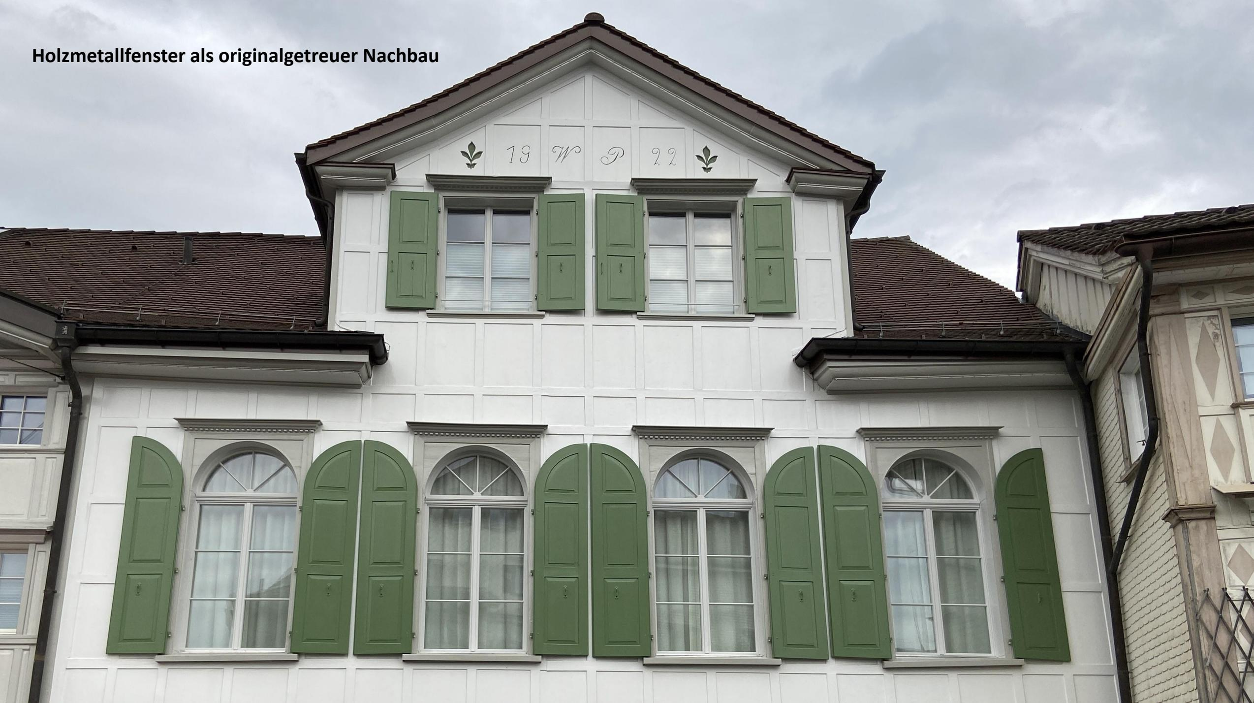
Einfachverglasung umgebaut zu Isolierverglasung
