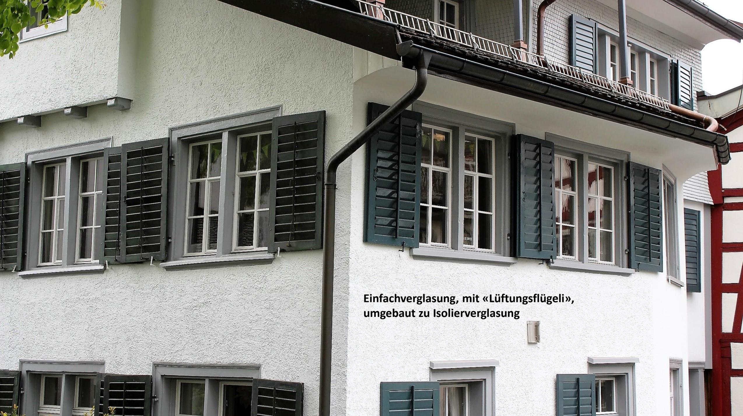
**Einfachverglasung, mit «Lüftungsflügeli»,
