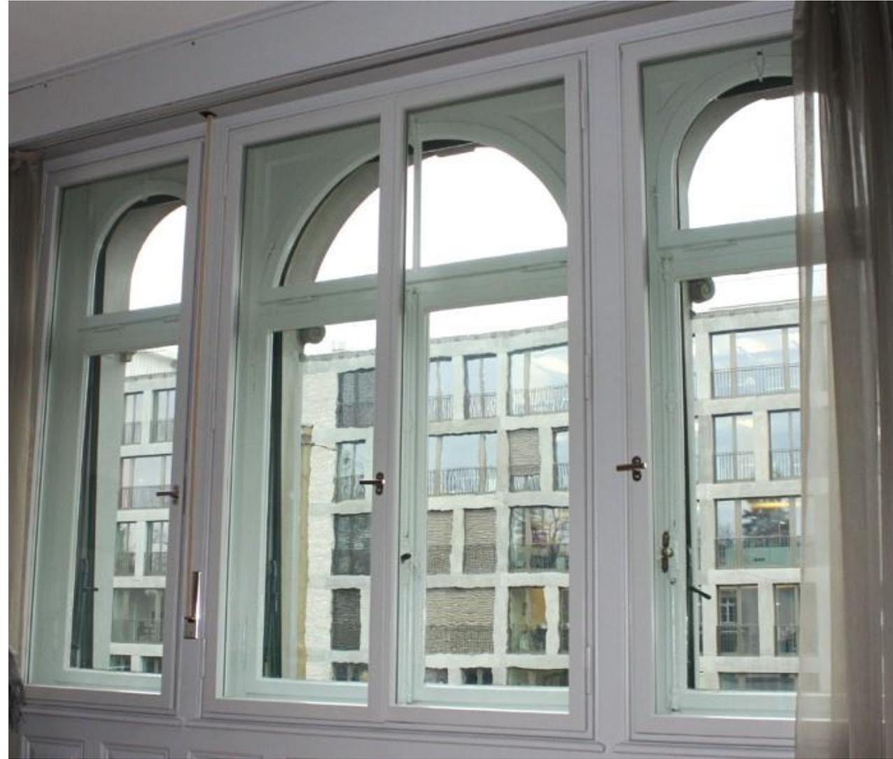
Einfachverglasung umgebaut zu Isolierverglasung
