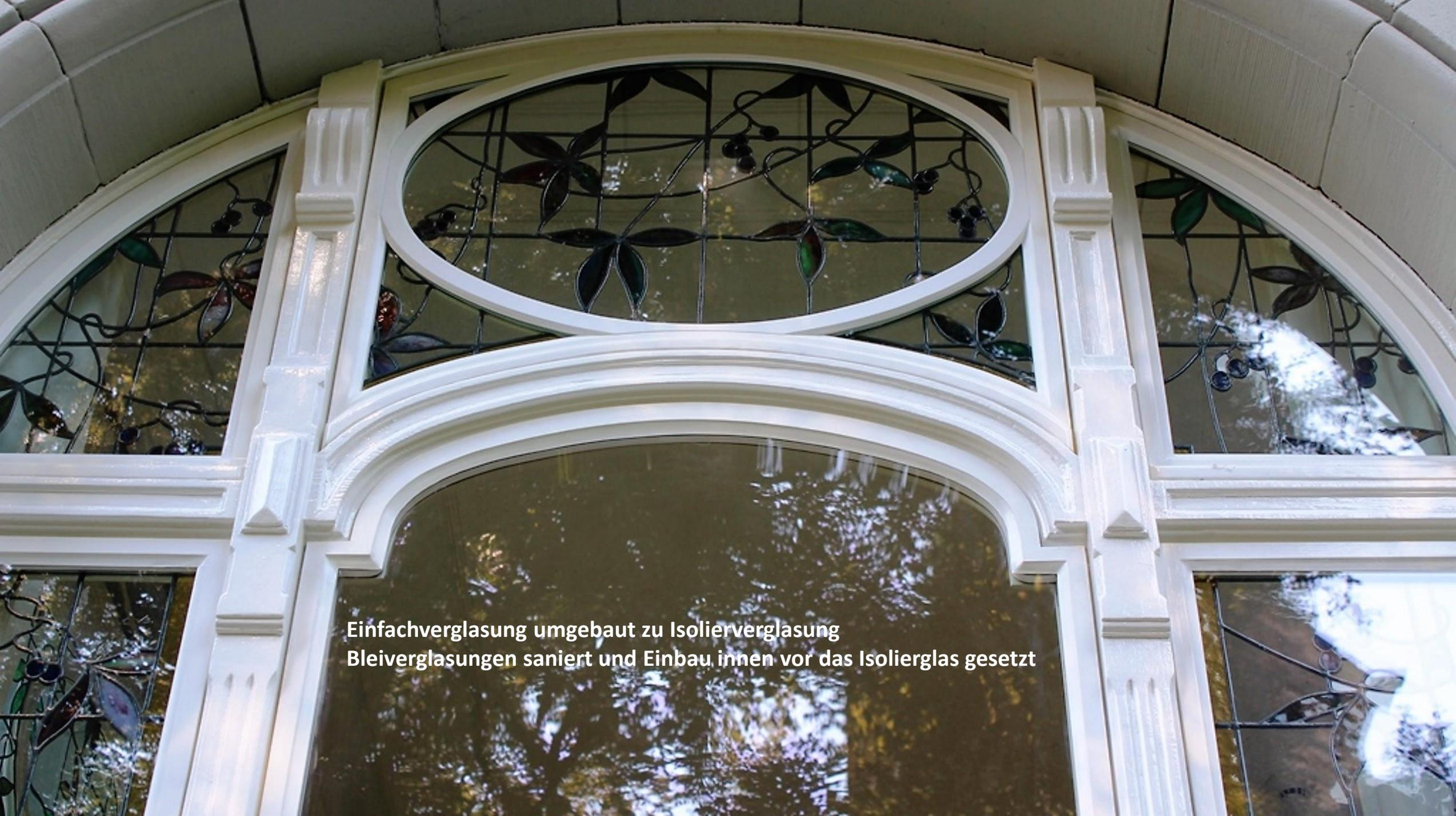
**Einfachverglasung umgebaut zu Isolierverglasung
